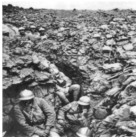
Tranchées sur le front franco-allemand
